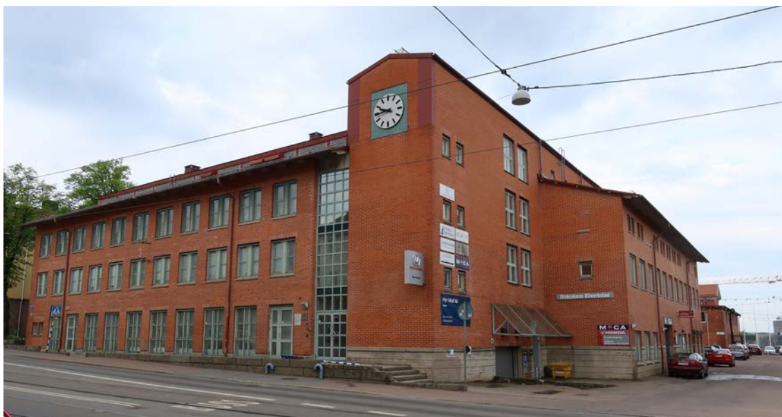
Fasad mot Ånäsvägen. och vy in mot gårdsmiljön.
