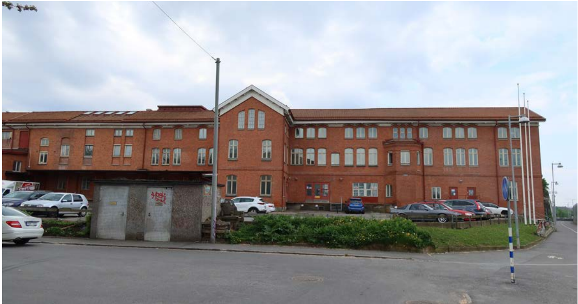
Byggnadsdel 1:A sedd från Ejder- gatan i norr.
