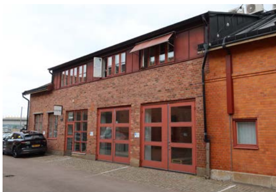
Den före detta verkstadsbyggnaden i väster sedd från gården.
